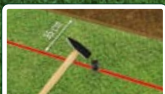
Провод по периметру
