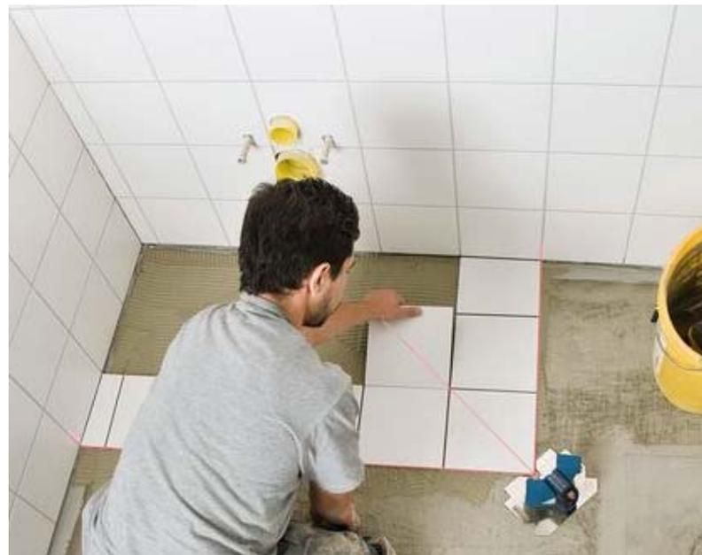
Становится намного проще определить правильные места стыков на полу и на стене.
