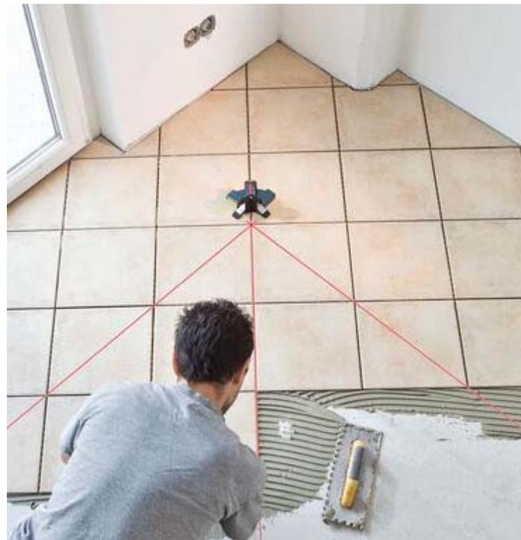
GTL 3 Prof. двигается за плиточником, так как он продолжает укладку плитки по диагонали. Таким образом 3 луча всегда хорошо видны.
